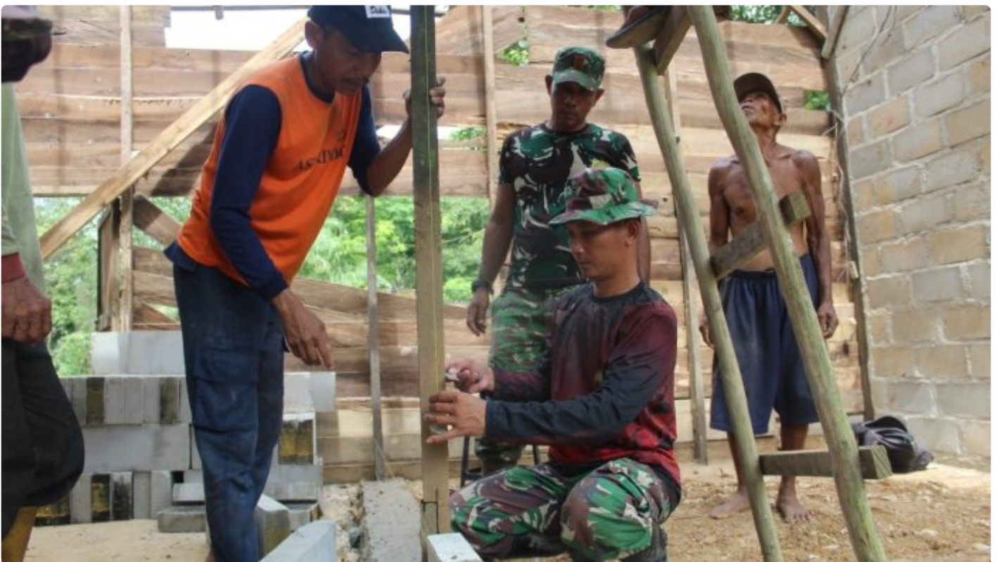
Sasaran Bedah Rumah, Sudah Tahap Pemasangan Dinding
