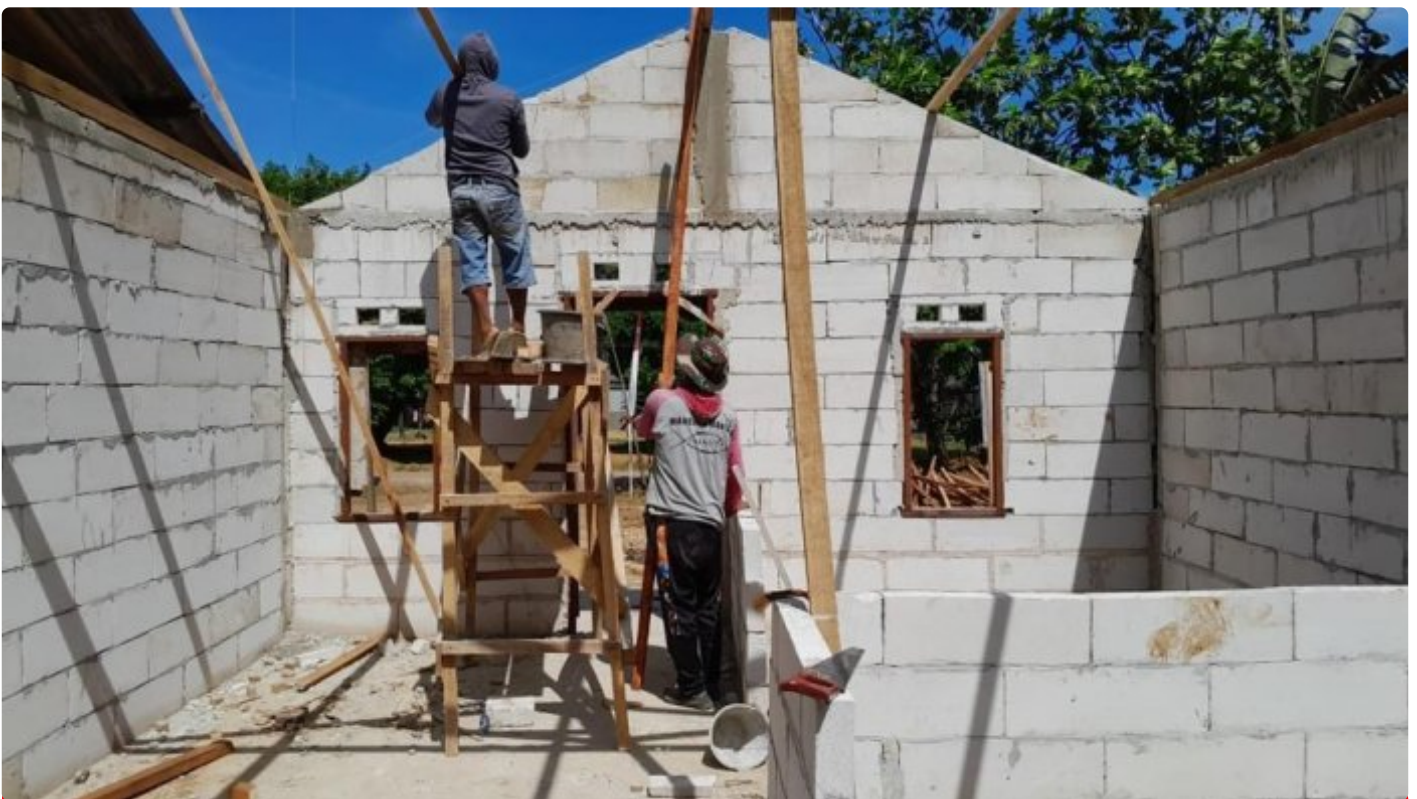
Rasa Haru Mbah Sandi Melihat Dinding Rumahnya Sudah Berdiri
