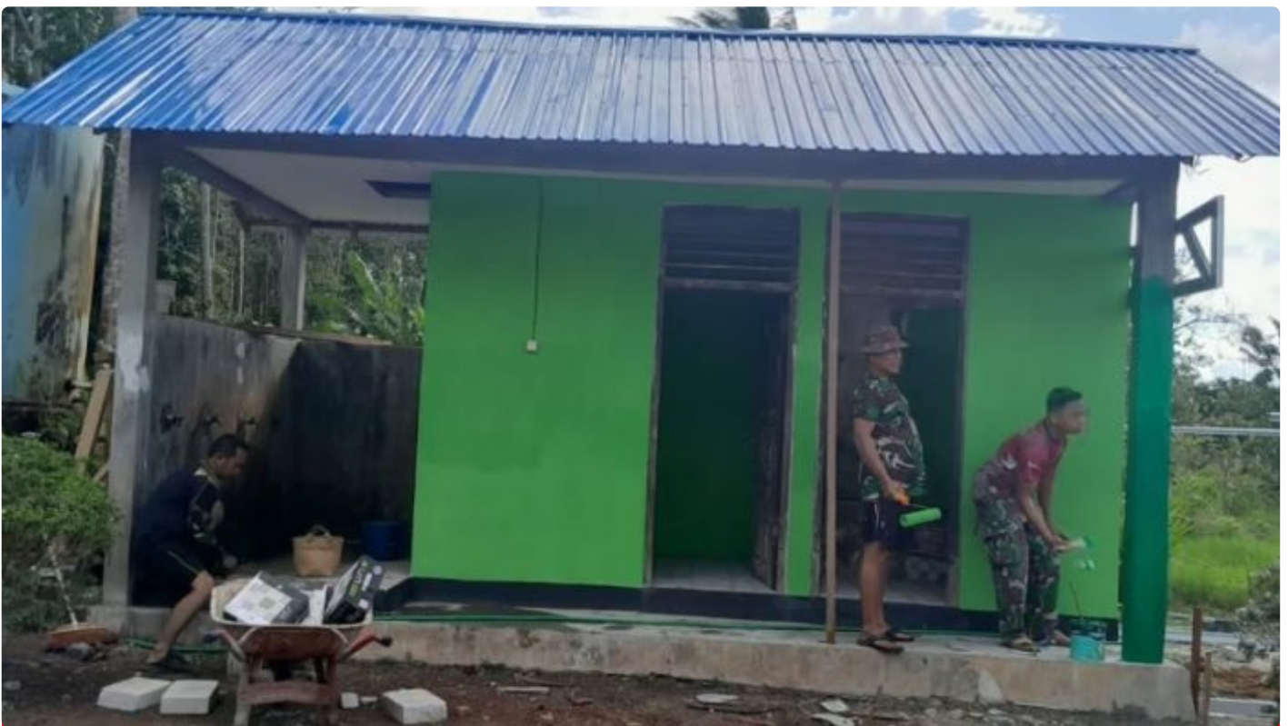
Pengerjaan Sasaran Rehab Masjid, Tinggal Finising
