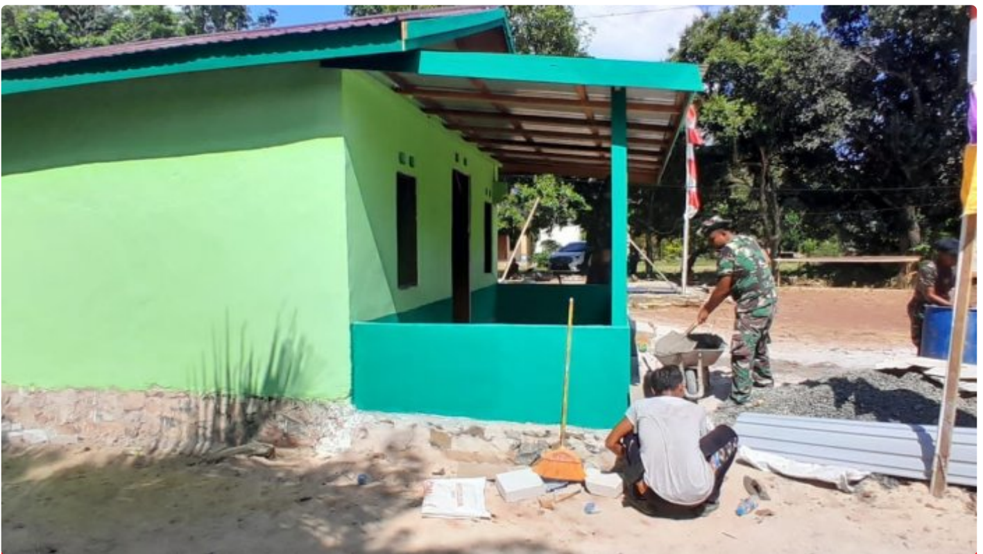
Pengerjaan Rumah Mbah Sandi Hampir Rampung
