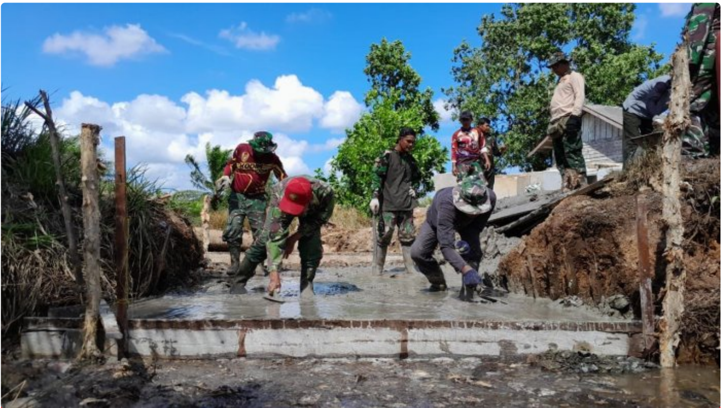
Memasuki Minggu Ke Dua, Satgas TMMD Mulai Cor Dasar Box Culvert
