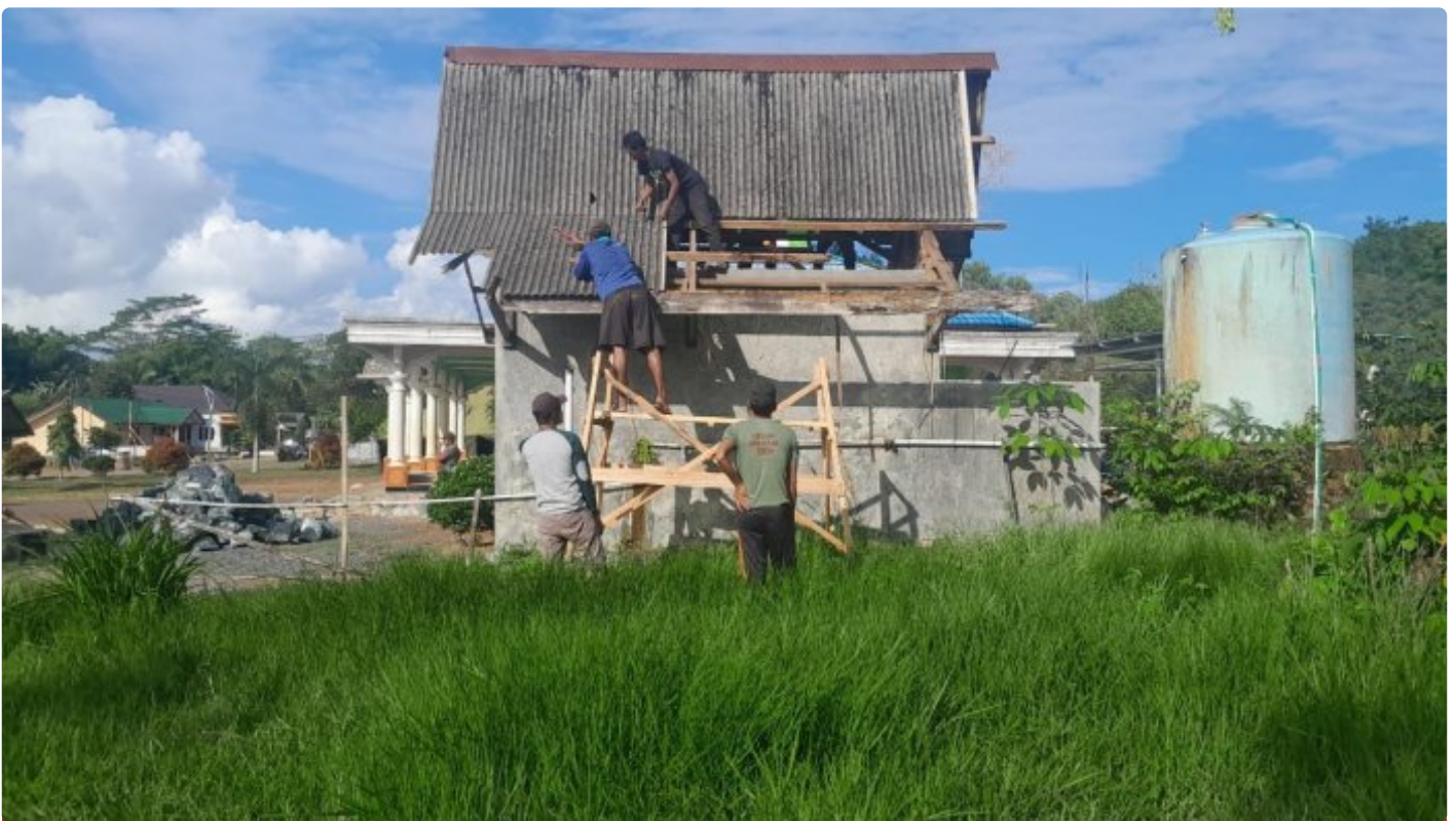
MCK Masjid Al Mujahidin Desa Telaga Langsat Dibongkar Satgas TMMMD Ke 117
