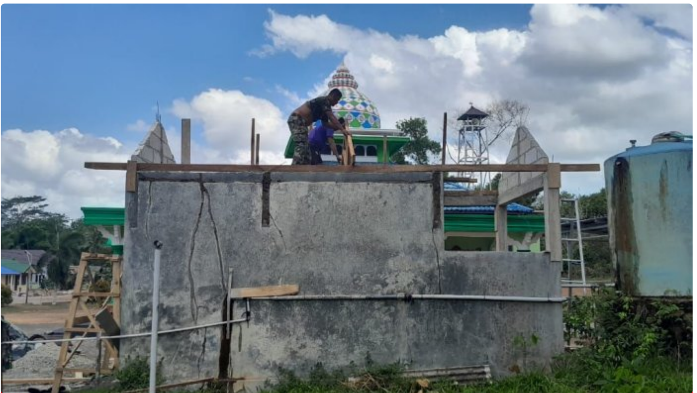
Masjid Rampung, Tempat Wudhu Dan MCK Masjid Al Mujahidin Dikebut Satgas TMMD
