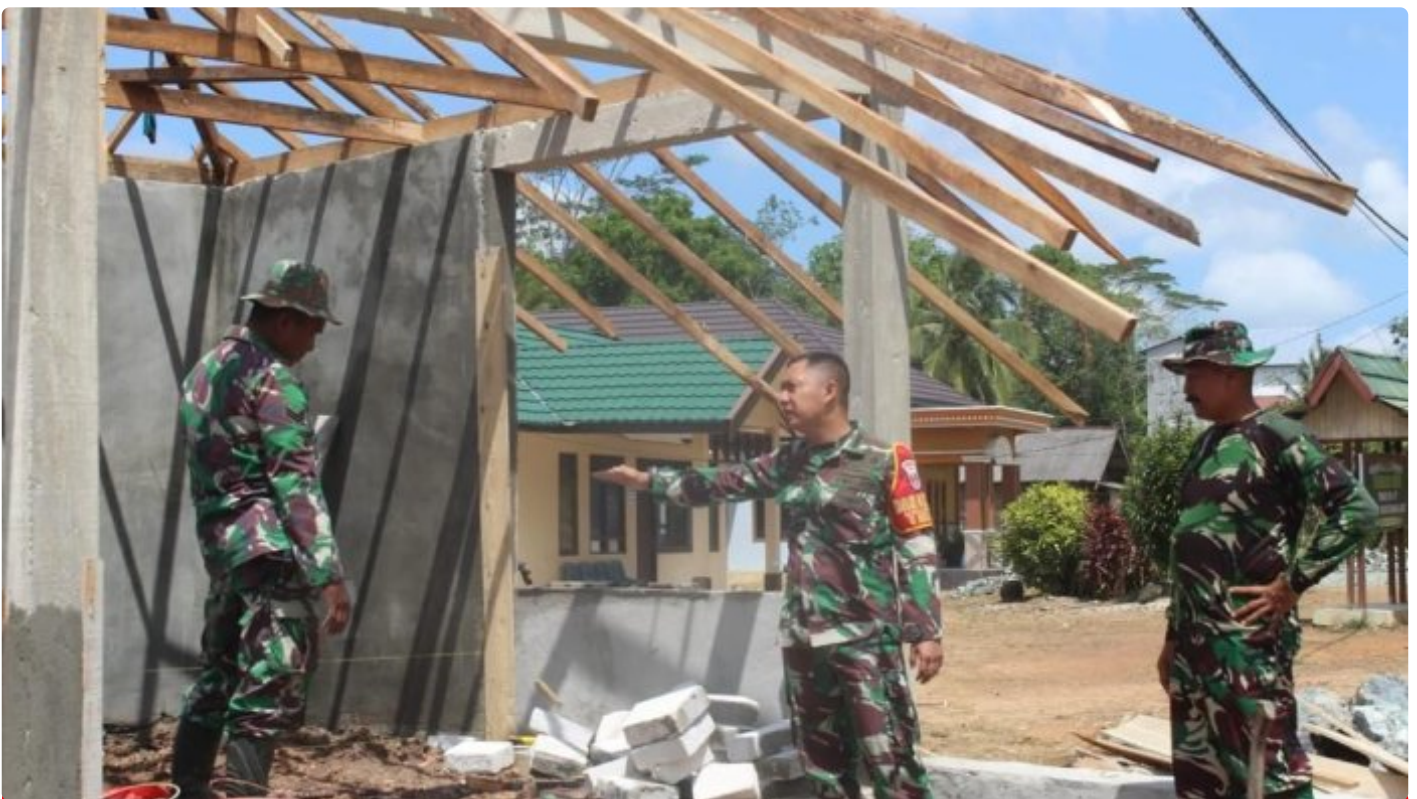
Dansatgas TMMD, Tinjau Langsung Perkembangan Dilapangan
