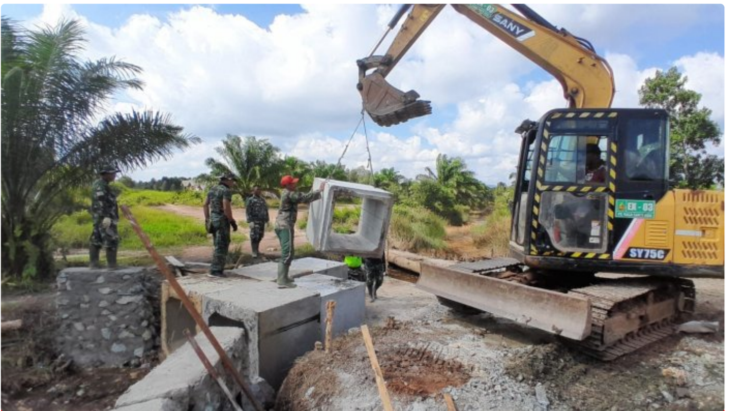
Box Culvert Jembatan Penghubung Desa Telaga Langsung Mulai Dipasang
